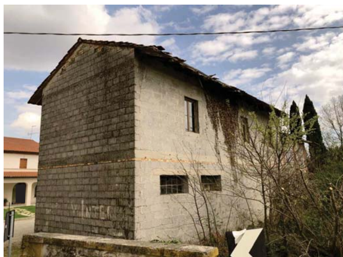
foto 3 vista da ovest
