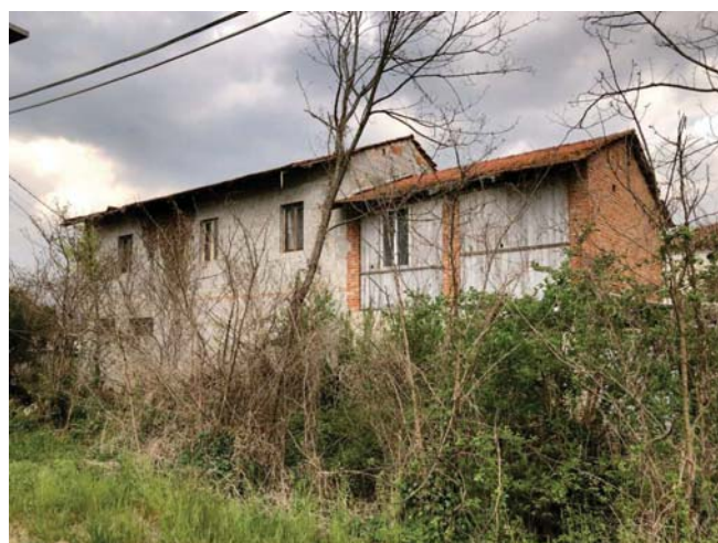
foto 4 vista da sud-ovest
